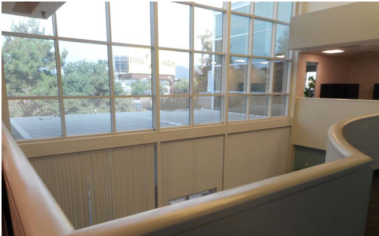
D1 PHOTO D1 - Existing Open Volume over Lobby
